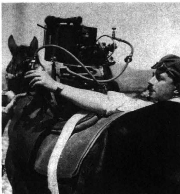
Simon Feldman: kamera na hřbetu koně je vedena pomocí stlačeného vzduchu
